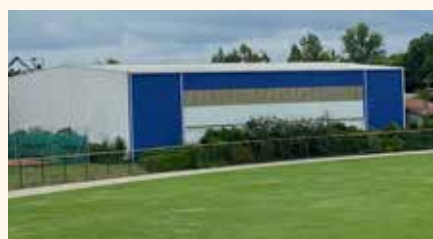
Etanchéité des salles 1 et 2 du Tennis avec reprise bardage et portail coulissant. Travaux réalisés par Sud-Ouest Montage (Montant : 10 148. 95 € TTC)
